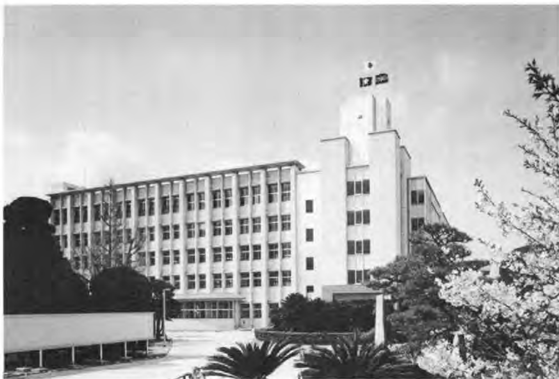
平成12年（2000年）校舎全面改装竣工写真
